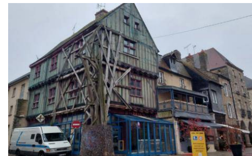
Immeuble des 7 Colonnes - Alençon (61)
